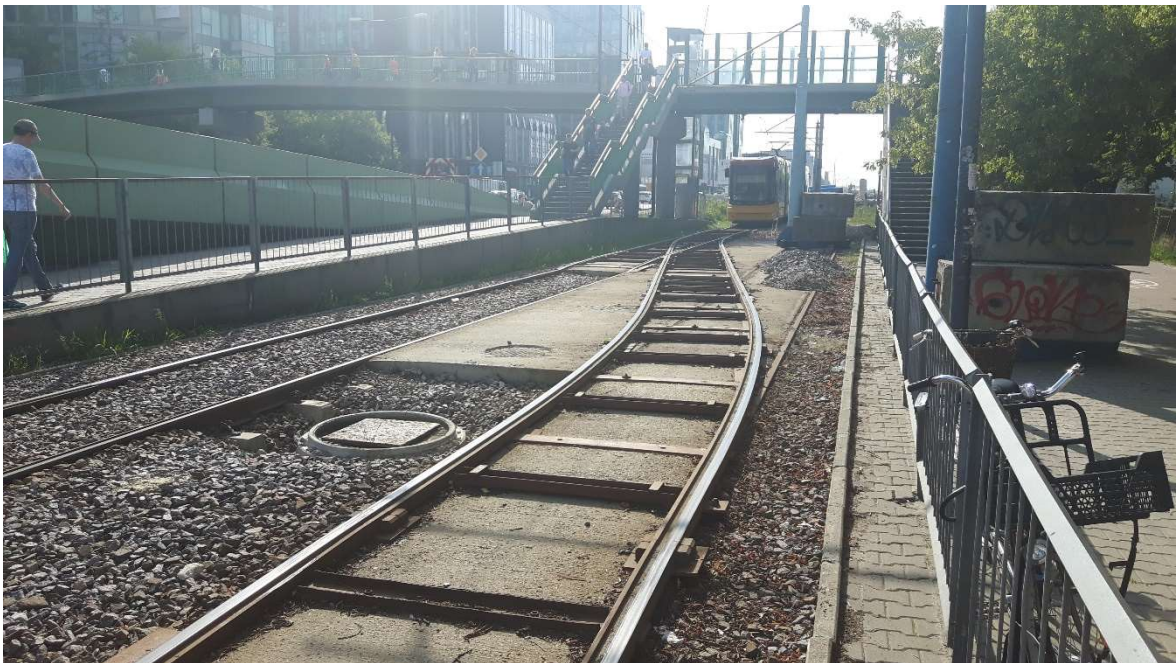
Rysunek 46. Wykorzystanie nakładki torowej przy remoncie ciągu ul. Marynarskiej, Warszawa (2018) Foto: K. Pietrzak
