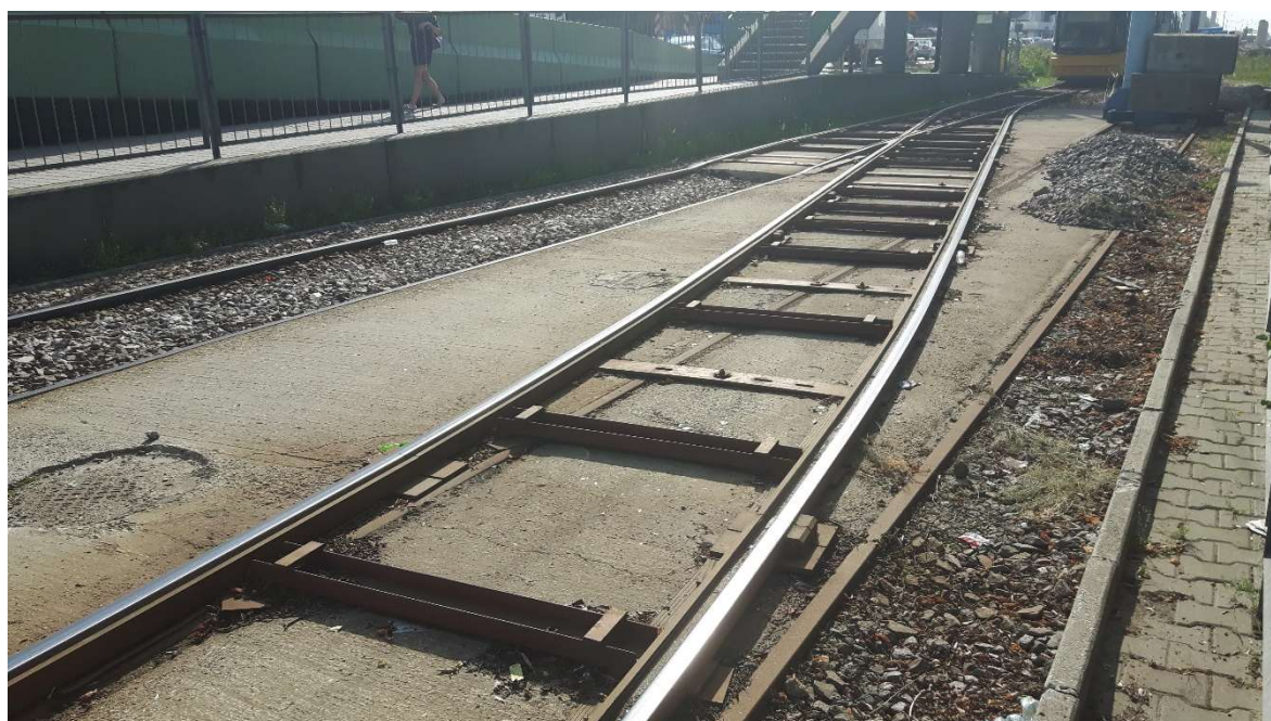
Rysunek 16. Nakładka tramwajowa, ul. Marynarska, Warszawa (2018) Foto: K. Pietrzak
