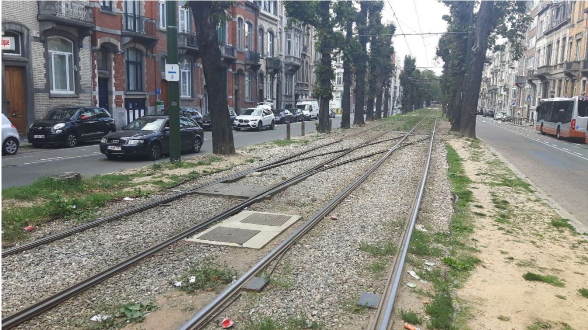
Rysunek 3. Łącznica torowa pozwalająca na zmianę toru po zmianie kierunku jazdy przez tramwaj dwukierunkowy, okolice przystanku „Vanderkindere”, Bruksela (2018)
