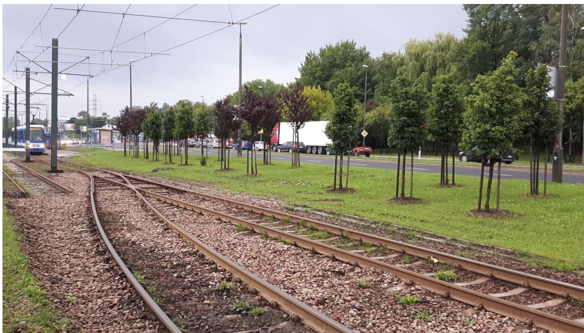
Rysunek 49. Tymczasowa krańcówka tramwajowa z rozjazdem w budowie, okolice przystanku „Kurdwanów”, Kraków (2018) Foto: O. Pietrzak
