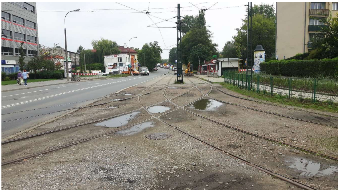
Rysunek 42. Trójkąt torowy, okolice przystanku „Dworcowa”, Kraków (2018) Foto: K. Pietrzak
