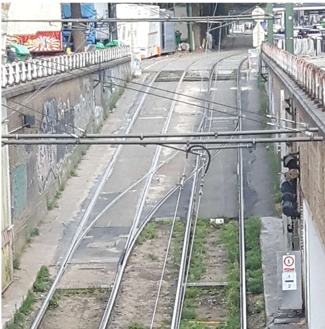
Rysunek 5. Przejścia torowe umożliwiające zawracanie taboru na trasie dwutorowej, okolice przystanku „Lemonnier”, Bruksela (2018) Foto: K. Pietrzak
