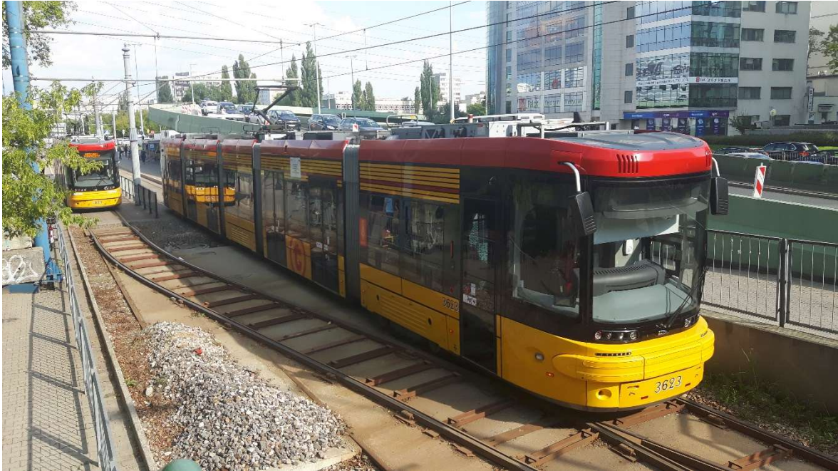
Rysunek 47. Eksploatacja tramwaju dwukierunkowego z wykorzystaniem nakładki torowej podczas remontu ciągu ul. Marynarskiej, Warszawa (2018) Foto: K. Pietrzak
