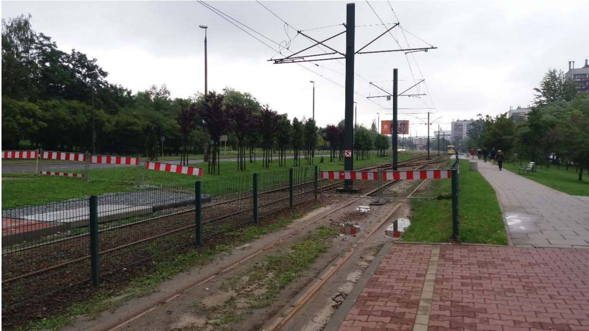
Rysunek 50. Tymczasowa krańcówka tramwajowa z rozjazdem w budowie, okolice przystanku „Kurdwanów”, Kraków (2018) Foto: O. Pietrzak
